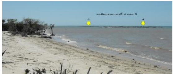
รอดักทรายบางตาวา-สายหมอ แนวที่ 4 และ 5
