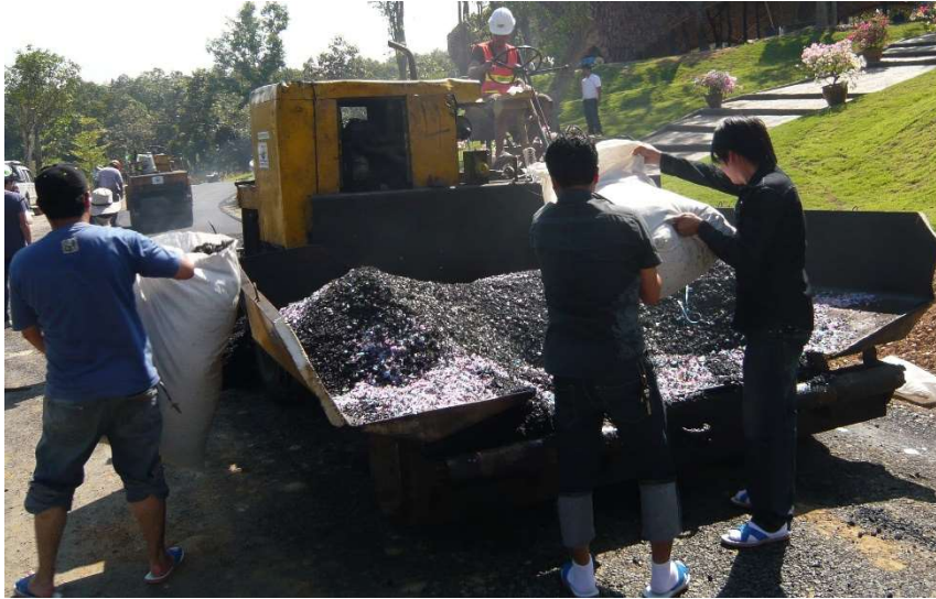
รูปที่ 7 การผสมขยะถุงพลาสติกลงไปในแอสฟัลต์คอนกรีตขณะก่อสร้างถนน
